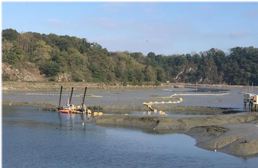
Dragage de sédiments sur le site de piégeage du Lyvet (La Vicomté-sur-Rance). Les sédiments extraits sont ensuite amenés sur la plateforme de transit de la Hisse à Saint-Samson-sur-Rance pour décantation et séchage.
